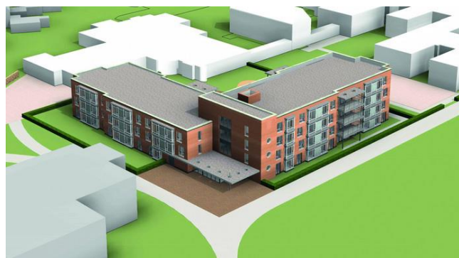
Nieuwbouw De Hofkamp
